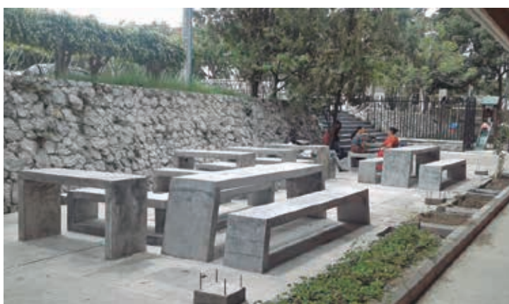
Construcción y mantenimiento de bancas
